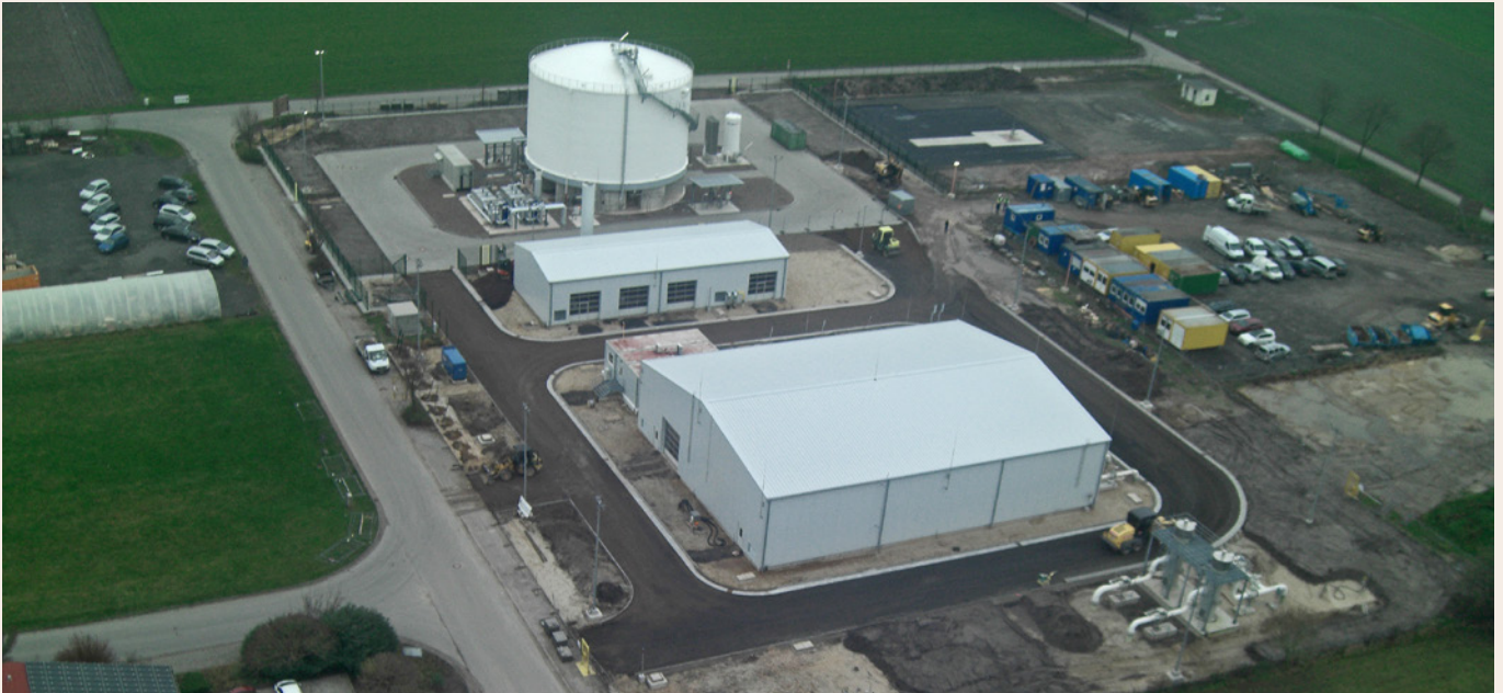
Bild 1: Übersicht der Konvertierungsanlage in Rehden [5]
