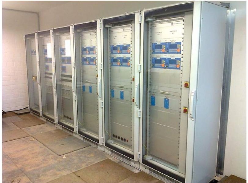
**Bild 6.** Schaltschränke der Firma RMG by Honeywell mit Messwertregistriergeräten des Typs MRG 2203, DSfG- und Profibusgateways, Ethernetrouter, sowie Flow Computer des Typs ERZ 2104 und Analysedatenrechner Typ GC9000 VC installiert im Elektroraum der Gasbetriebseinrichtungen [9].
