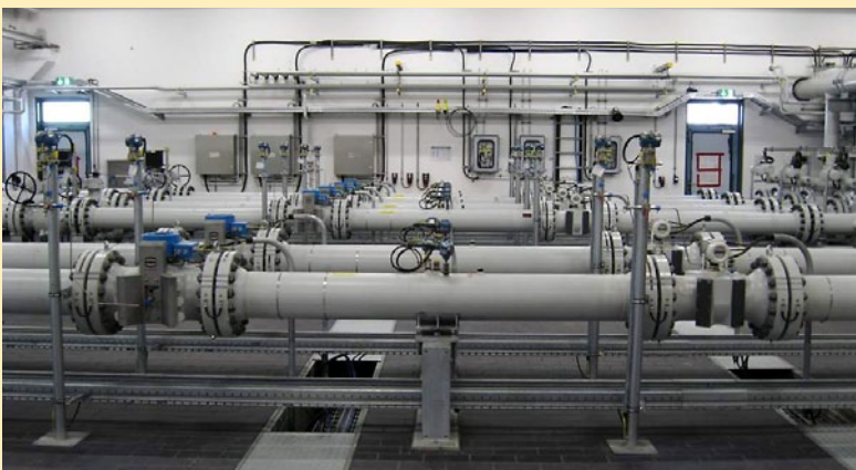
Bild 5. Ultraschallgaszähler USZ 08 der Firma RMG by Honeywell mit einem Ultraschallgaszähler FlowSic 600 der Firma Sick in einer Dauerreihenschaltung [8].
